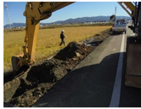
写真-4 表土剥取作業
