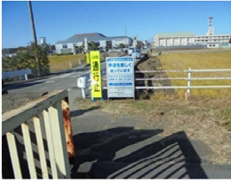
写真-5 岩崎橋より工事区間を望む
