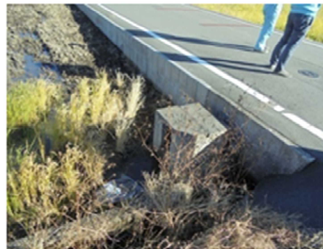
写真-8 農業用給水栓（道路区域外へ移設予定）
