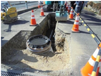
写真－5 私道でのマンホール設置
