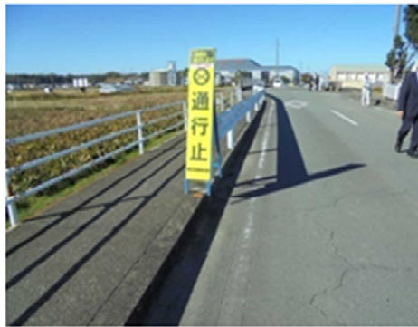
写真-7 岩崎橋南側から岩崎橋を望む（前方横断歩道は確認できない）
