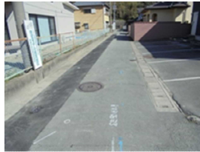
写真－4 事務所南側下水管渠敷設
