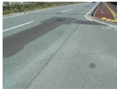
写真－6 県道部耐硫酸性マンホール
