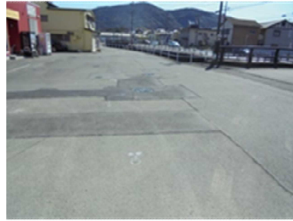
写真－2 河川区域での下水管渠敷設
