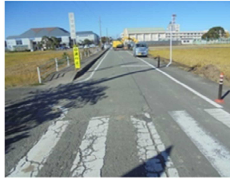
写真-6 岩崎橋北側横断歩道
