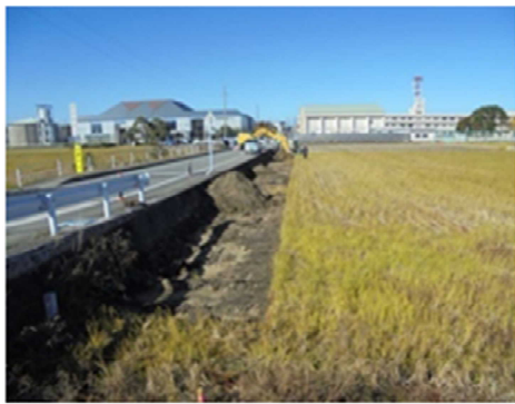
写真-3 表土剥取（後方小学校）
